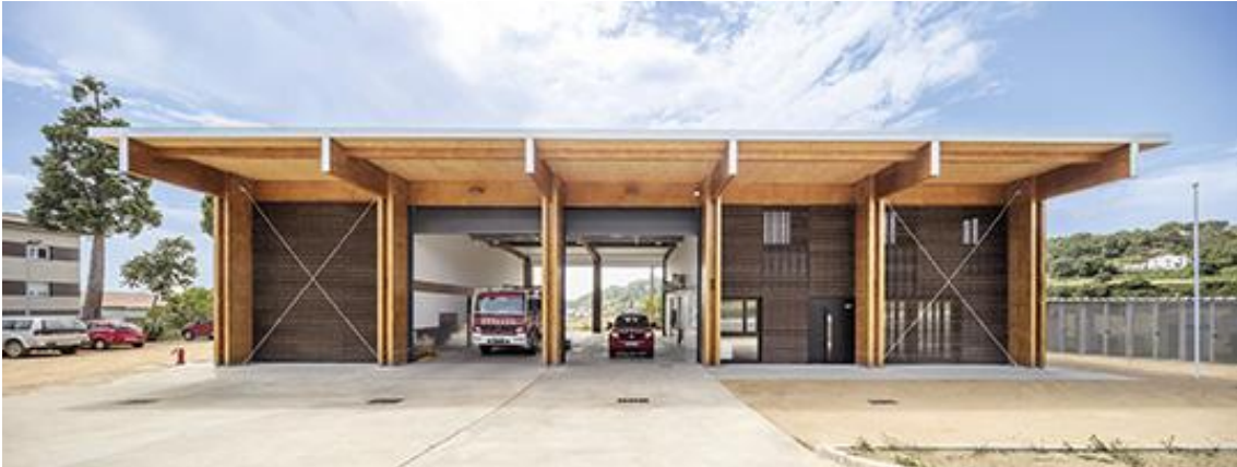
Parque de Bomberos, Moia, 2020. Arquitectos: Josep Ferrando, Pedro Garcia, Mar Puig de la Bellacasa, Manel Casellas. Foto: Adrià Goula
