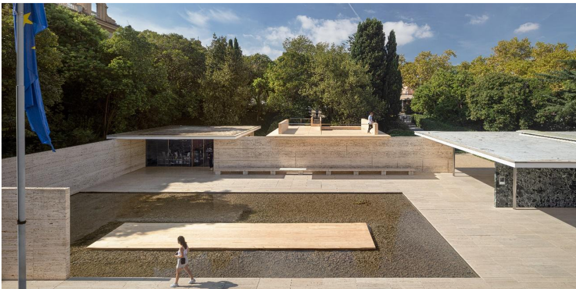
Mass is More. Instalación de CLT en el Pabellón de Mies van der Rohe en 2022 donde se inauguró la red Mass Madera. Autores: Daniel Ibáñez, Vicente Gualart y Alan Organschi. Foto, Adrià Goula.
